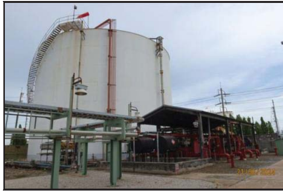
ภาพถ่ายที่ 2.2.2-42 ถังสำรองน้ำดับเพลิงและปั้มน้ำดับเพลิง
