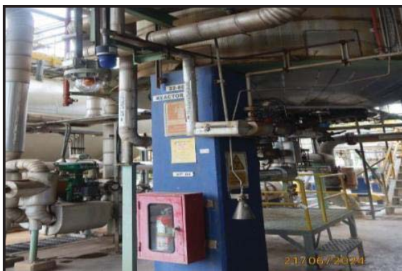
ภาพถ่ายที่ 2.2.2-27 Combustion Gas Detector และ Toxic Gas Detector
