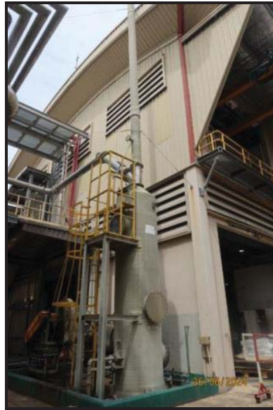
ภาพถ่ายที่ 2.2.2-4 Wet Scrubber ของเครื่อง Small Lot Extruder
