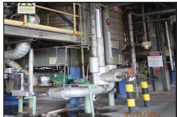
ภาพถ่ายที่ 2.2.2-27 Combustion Gas Detector และ Toxic Gas Detector
