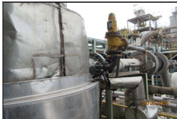
ภาพถ่ายที่ 2.2.2-35 Rupture Disc & Blowdown Tanks
