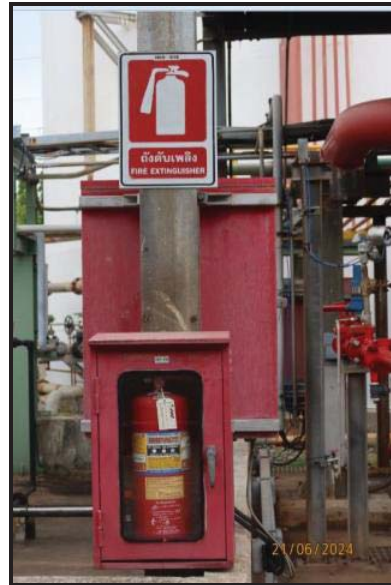
ภาพถ่ายที่ 2.2.2-30 ระบบดับเพลิงแบบเคลื่อนที่
