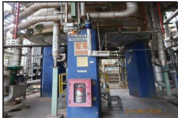
ภาพถ่ายที่ 2.2.2-6 อุปกรณ์ตรวจจับก๊าซและเตือน (Detection & Alarm)
