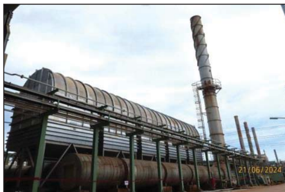
ภาพถ่ายที่ 2.2.2-2 Regenerative Thermal Oxidizer (RTO)
