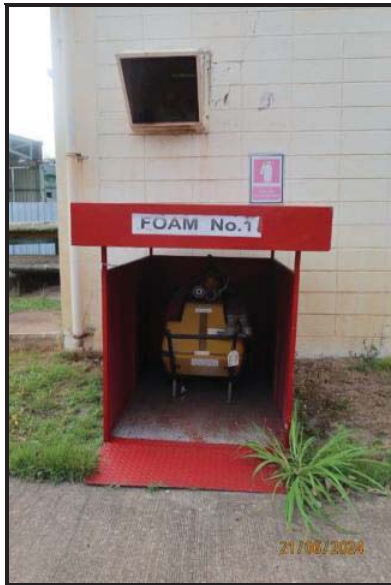
ภาพถ่ายที่ 2.2.2-30 ระบบดับเพลิงแบบเคลื่อนที่
