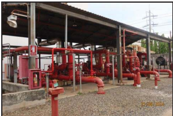
ภาพถ่ายที่ 2.2.2-41 ระบบน้ำดับเพลิงฉุกเฉิน
