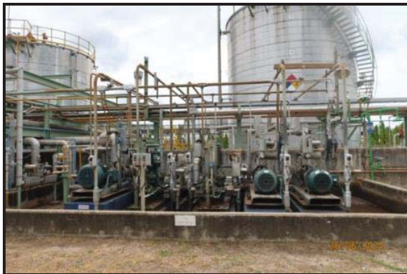
ภาพถ่ายที่ 2.2.2-5 ระบบ Double Seal Liquid Buffer
