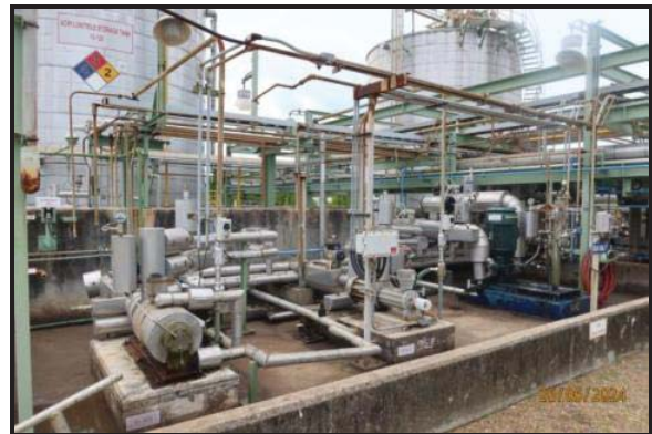
ภาพถ่ายที่ 2.2.2-5 ระบบ Double Seal Liquid Buffer
